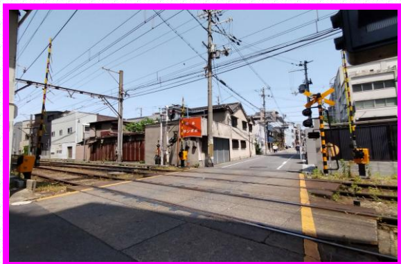
（神ノ木 5 号踏切道）
