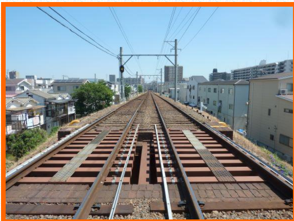
(安立川橋梁) ※我孫子道—大和川間
