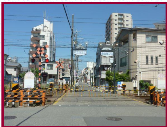
(安立町3号踏切道)
